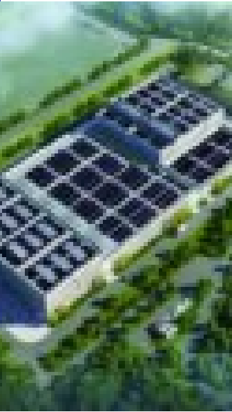
▲工商业分布式光伏——对接工业产业园、制造园区、服务区、工业厂房、牧场等位置工商业分布式光伏项目
